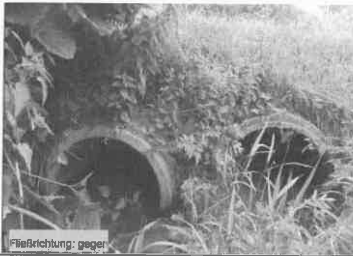
Abb.7: Unterquerung eines Feldweges
